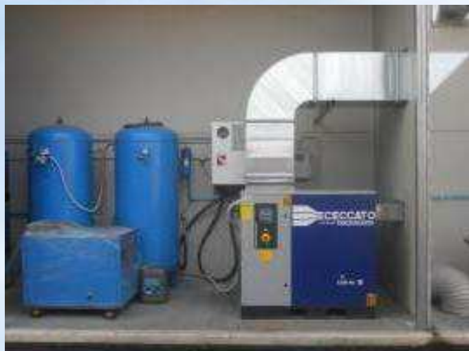
Centrale Aria: Compressore rotativo a vite, serbatoi, essicatore , filtri
